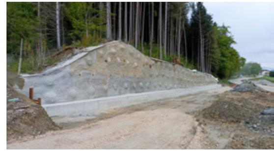
Errichtung der Stützmauer aus Naturstein im Bereich Neukling.
