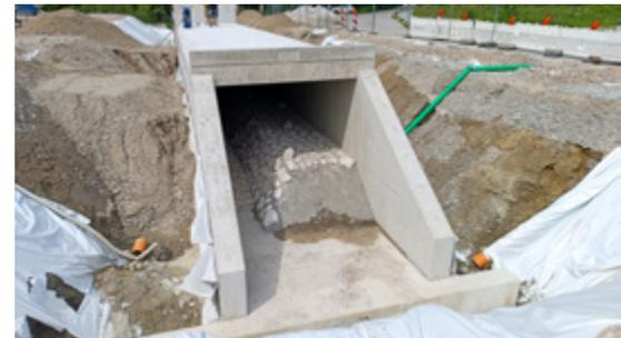
Betonarbeiten des Durchlasses unter dem zukünftigen Kreisverkehr einschl. Wartungsschacht und Steinversatz abgeschlossen.
