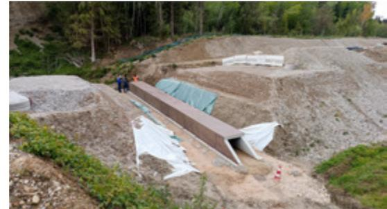
Fertigstellung des Amphibiendurchlasses und Hinterfüllung.
