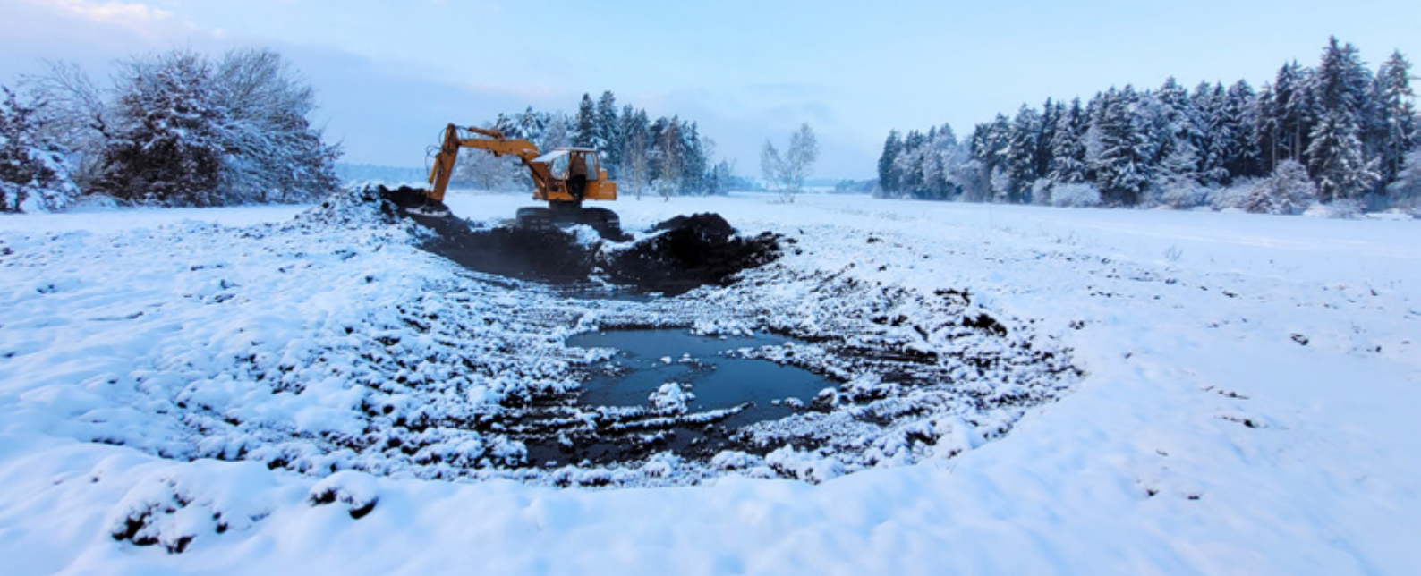
Hans Hofmeister bei den Baggerarbeiten
