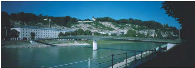
Neubau Makartsteg Salzburg
