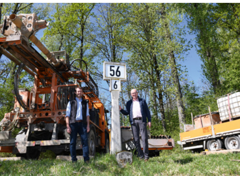
Bürgermeister Andreas Buchwinkler (links) und Landrat Bernhard Kern machten sich bei der Einweisung zu den Probebohrungen ein Bild. Bild: © tw
