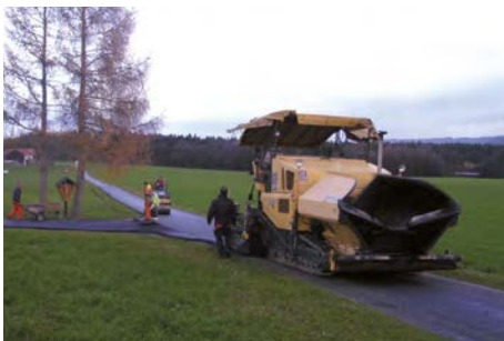
Straßensanierungsarbeiten im Gemeindegebiet
