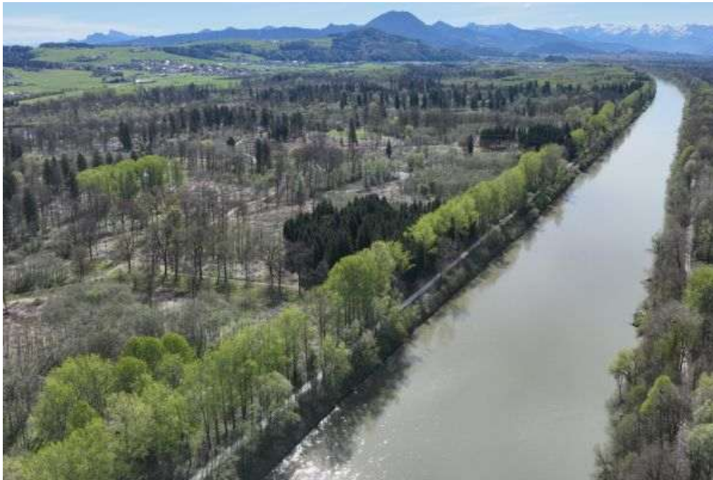
Die Salzach auf Höhe von Surheim vor der Umgestaltung.
